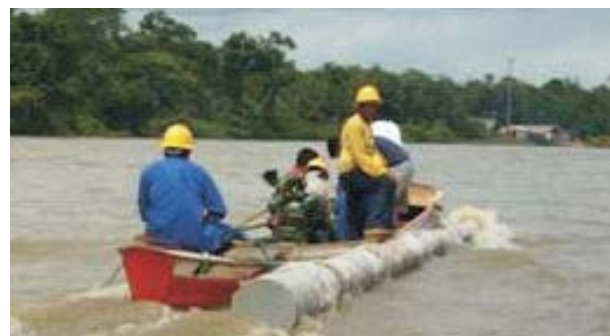
O transporte dos postes foi facilitado com a utilização de fibra de vidro. Agora ele até flutua ao lado dos barcos
