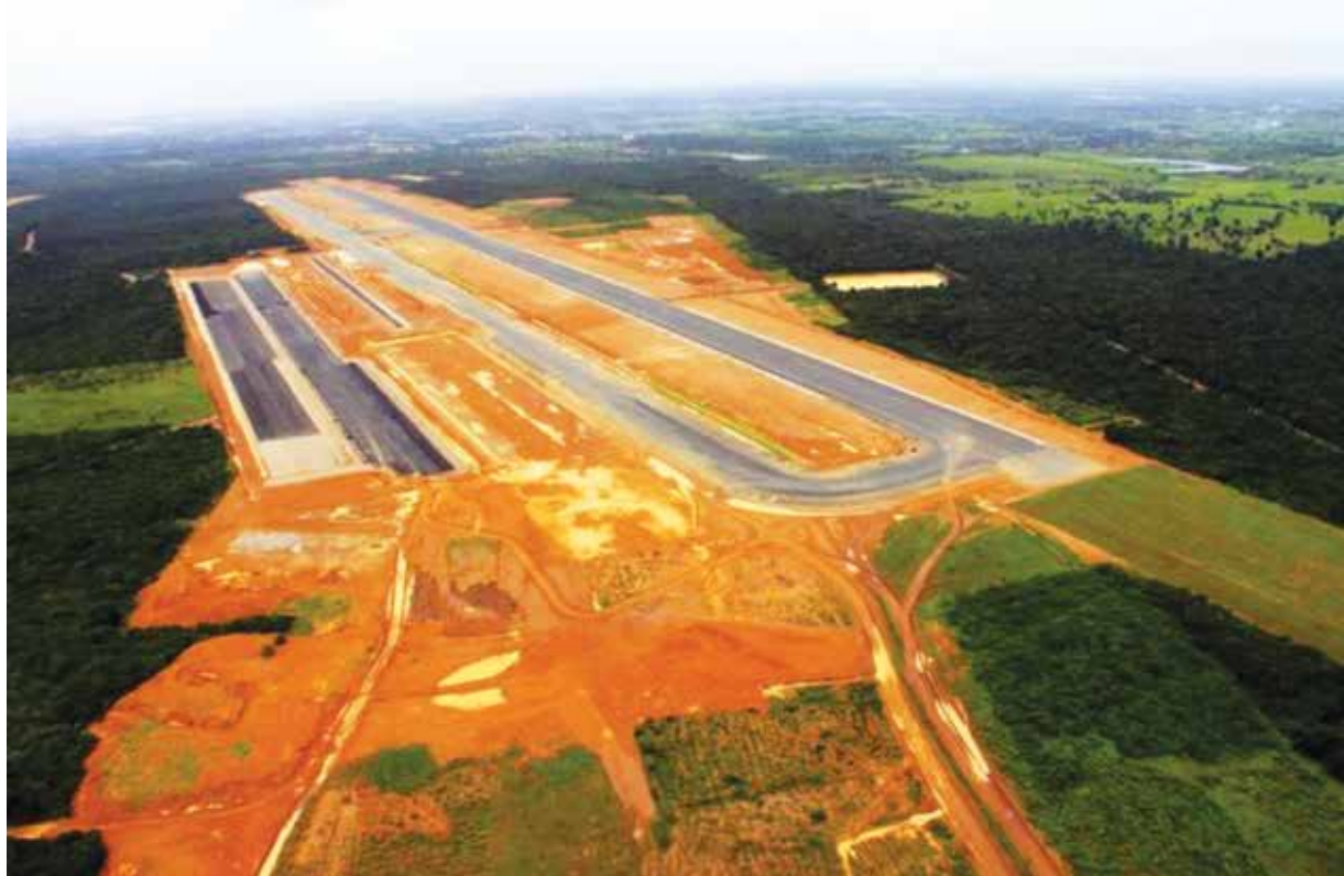
Obras da pista do Aeroporto de São Gonçalo do Amarante – 2011
